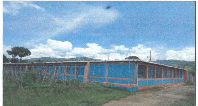
Foto 2: EORM CASERIO LOS ANGELES, COMITANCILLO, SAN MARCOS, CUBIERTO DE LAMINAS. LADO SUR Y ORIENTE.
